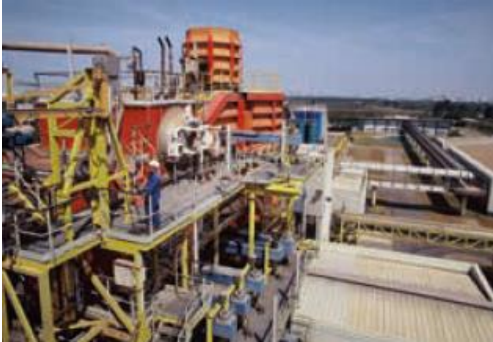
Incinérateur Solamat Merex (Fos sur Mer – 13) Valorisation énergétique
