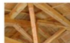
Structure, Maçonnerie, Charpente
